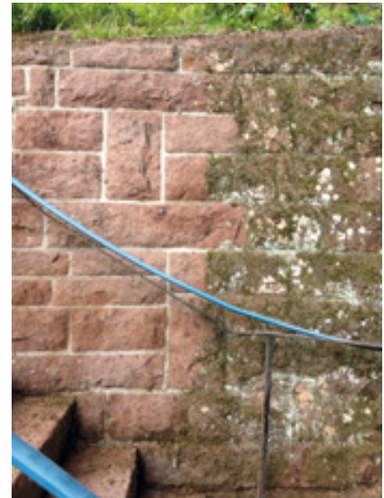
Sandsteinmauer; durchgeführte Arbeit: Moosteppich entfernt
