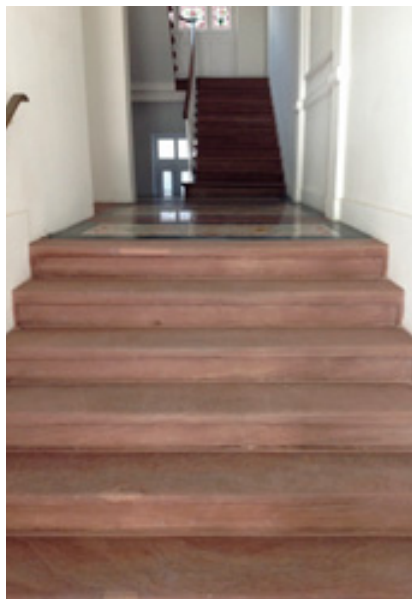
Terrazzo- und Sandsteinböden in einem Heidelberger Hotel; durchgeführte Arbeiten: PVC entfernt, Ausbesserungen (dem Bestandsmaterial angepasst), gemäß UVV R9 geschliffen und kristallisiert (Terrazzo) bzw. imprägniert (Sandstein)
