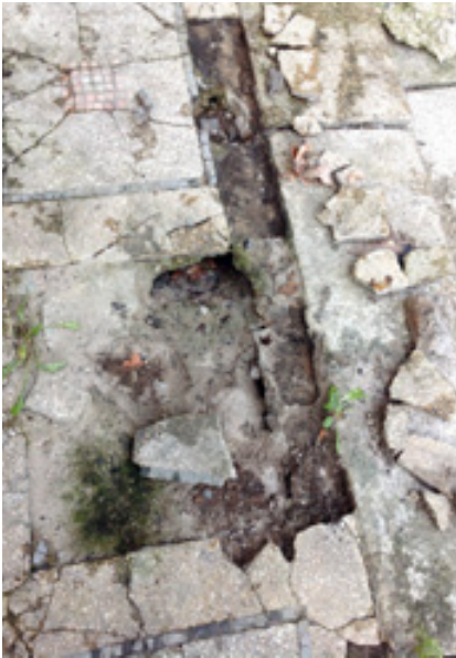
»Terrazzo«-Boden im Eingang der Uniklinik Homburg, denkmalgeschützt; durchgeführte Arbeiten: Unterboden vorbereitet, ausgebessert (dem Bestandsmaterial angepasst), geschliffen und imprägniert
