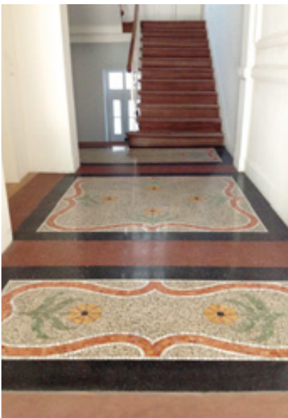
Terrazzo- und Sandsteinböden in einem Heidelberger Hotel; durchgeführte Arbeiten: PVC entfernt, Ausbesserungen (dem Bestandsmaterial angepasst), gemäß UVV R9 geschliffen und kristallisiert (Terrazzo) bzw. imprägniert (Sandstein)
