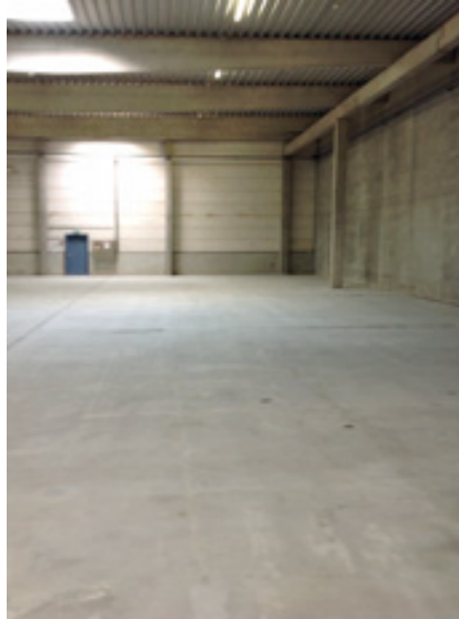
Betonstrichboden in einer Industriehalle in Helmstadt-Bargen; durchgeführte Arbeiten: geschliffen, ausgebessert und imprägniert
