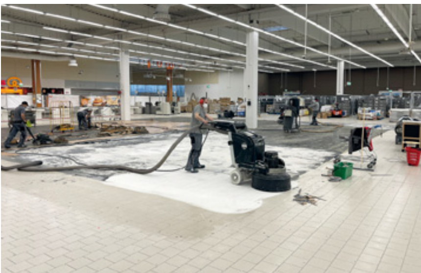
Feinsteinzeugfliesen in einem Verbrauchermarkt in Bedburg; durchgeführte Arbeiten: PVC entfernt, Ausgleichsmasse und Kleber entfernt, gemäß UVV R9 geschliffen und imprägniert
