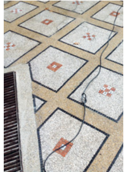
»Terrazzo«-Boden im Eingang der Uniklinik Homburg, denkmalgeschützt; durchgeführte Arbeiten: Unterboden vorbereitet, ausgebessert (dem Bestandsmaterial angepasst), geschliffen und imprägniert
