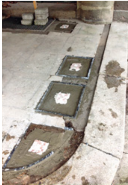
»Terrazzo«-Boden im Eingang der Uniklinik Homburg, denkmalgeschützt; durchgeführte Arbeiten: Unterboden vorbereitet, ausgebessert (dem Bestandsmaterial angepasst), geschliffen und imprägniert
