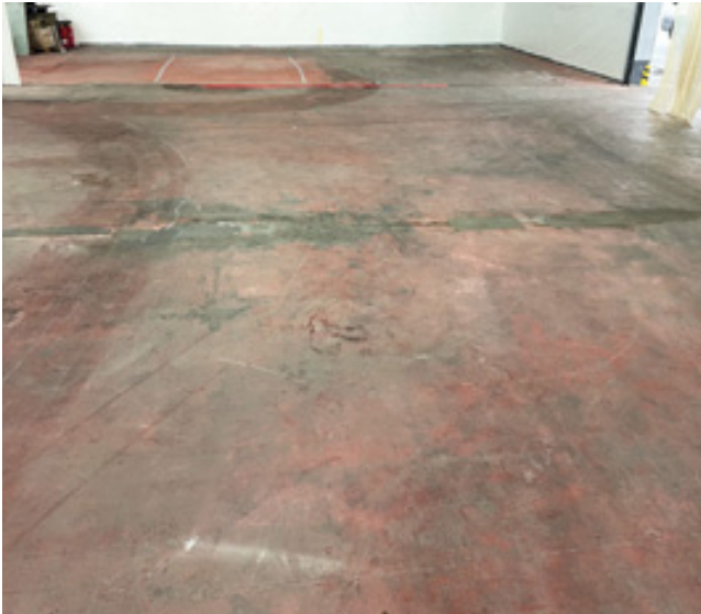
Magnesia-Estrichboden in einer Industriehalle in Neidenstein; durchgeführte Arbeiten: tiefengereinigt und imprägniert
