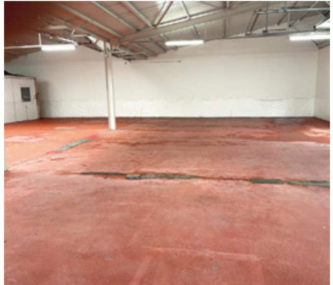
Magnesia-Estrichboden in einer Industriehalle in Neidenstein; durchgeführte Arbeiten: tiefengereinigt und imprägniert
