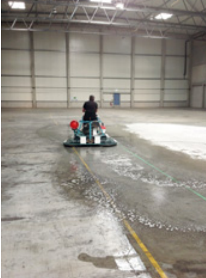
Betonstrichboden in einer Industriehalle in Helmstadt-Bargen; durchgeführte Arbeiten: geschliffen, ausgebessert und imprägniert
