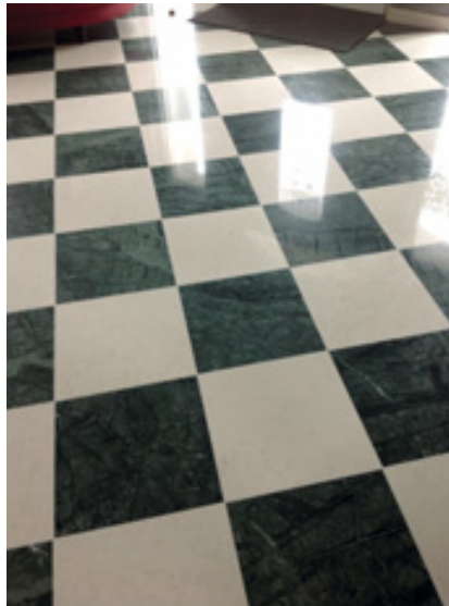
Marmorboden; durchgeführte Arbeiten: geschliffen, ausgebessert und imprägniert
