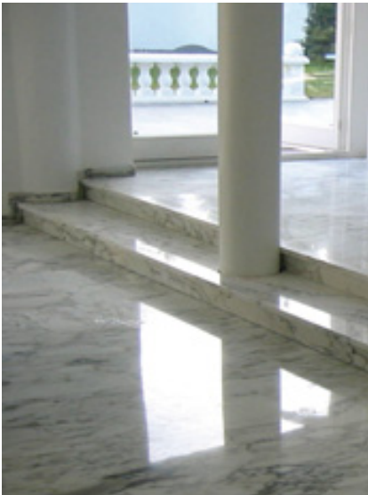
Marmorboden; durchgeführte Arbeiten: geschliffen, ausgebessert und imprägniert
